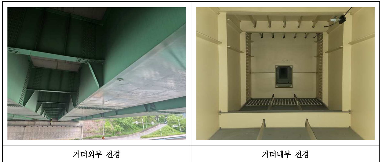
【사진 44.3.4】 거더 전경
