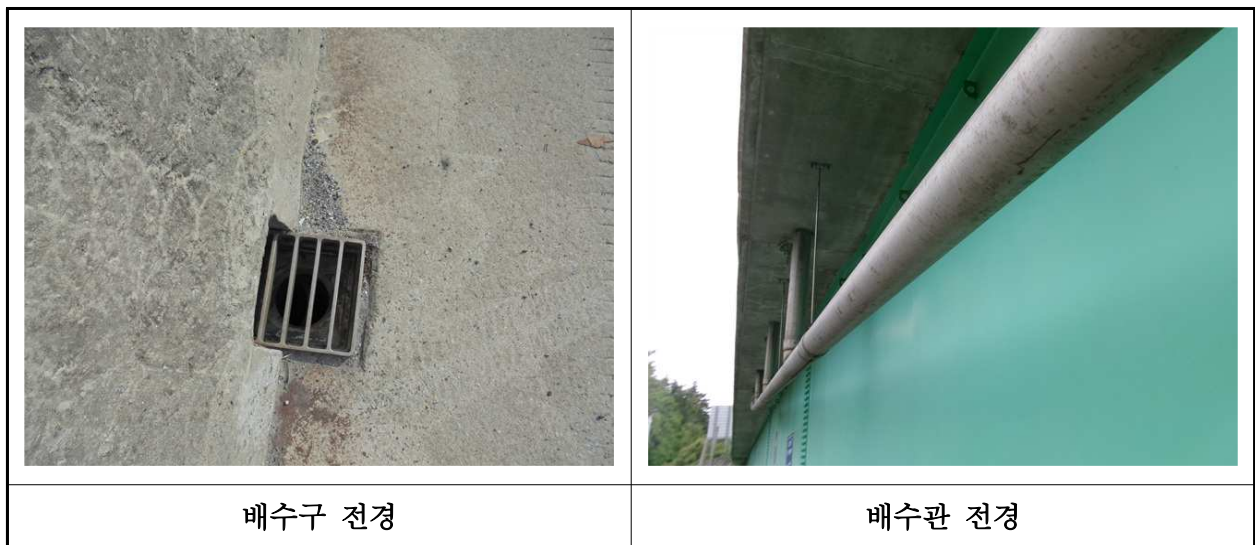
【사진 44.3.20】 배수시설 전경
