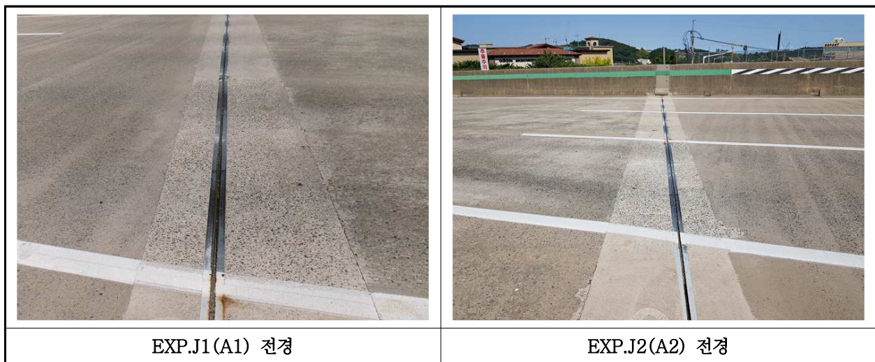
【사진 44.3.15】 신축이음장치 전경
