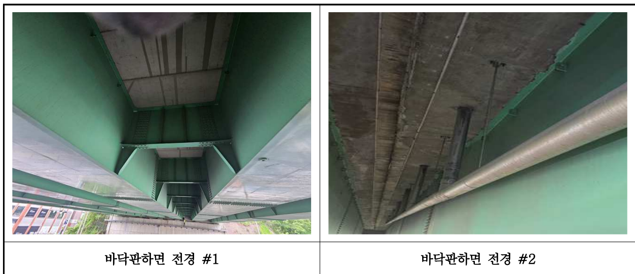
【사진 44.3.2】 바닥판하면 전경
