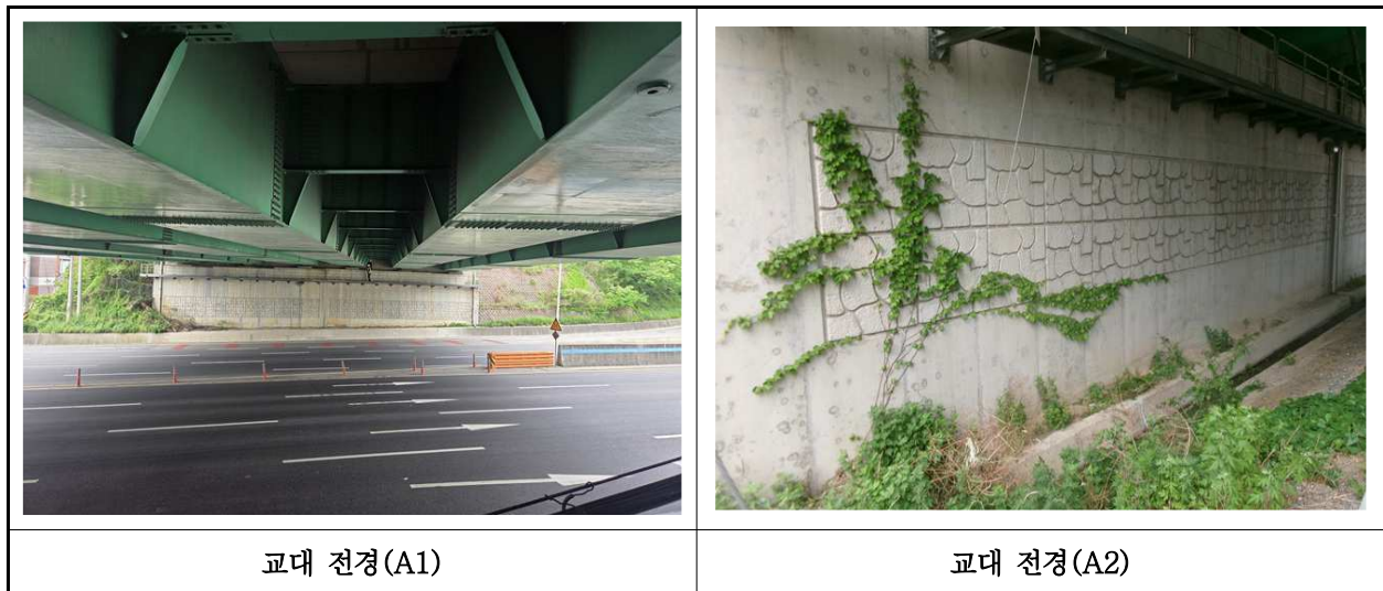
【사진 44.3.8】 교대 전경
