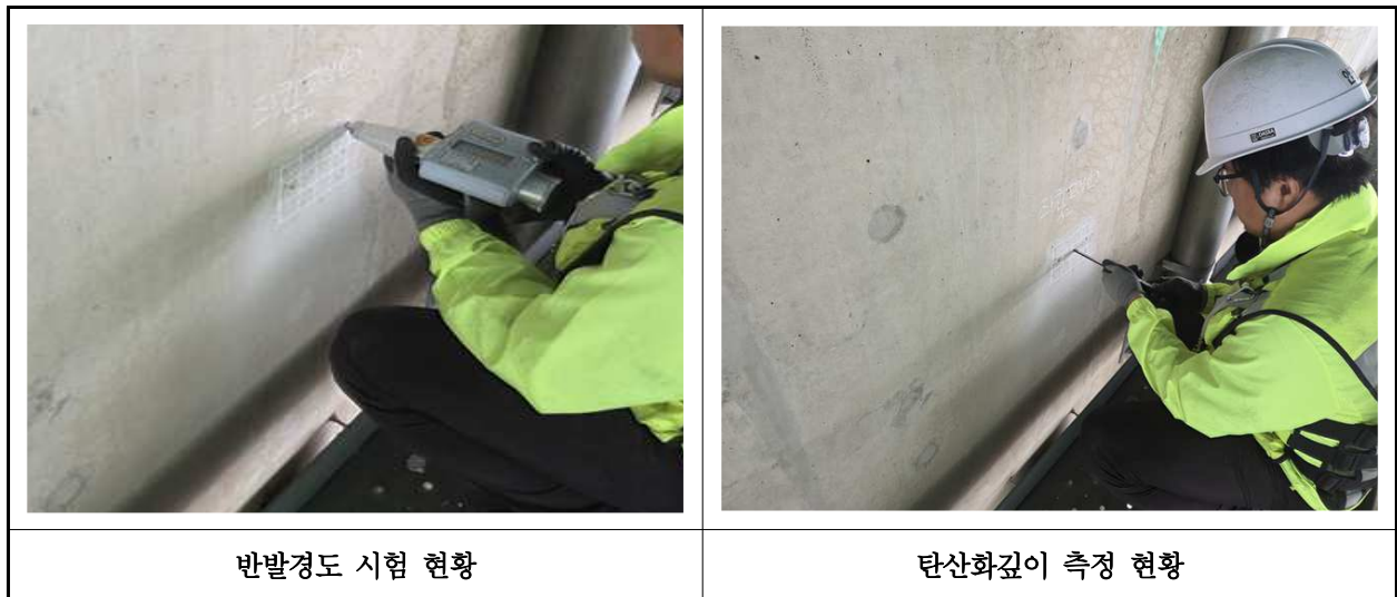
【사진 44.4.1】 콘크리트 내구성조사 현황
