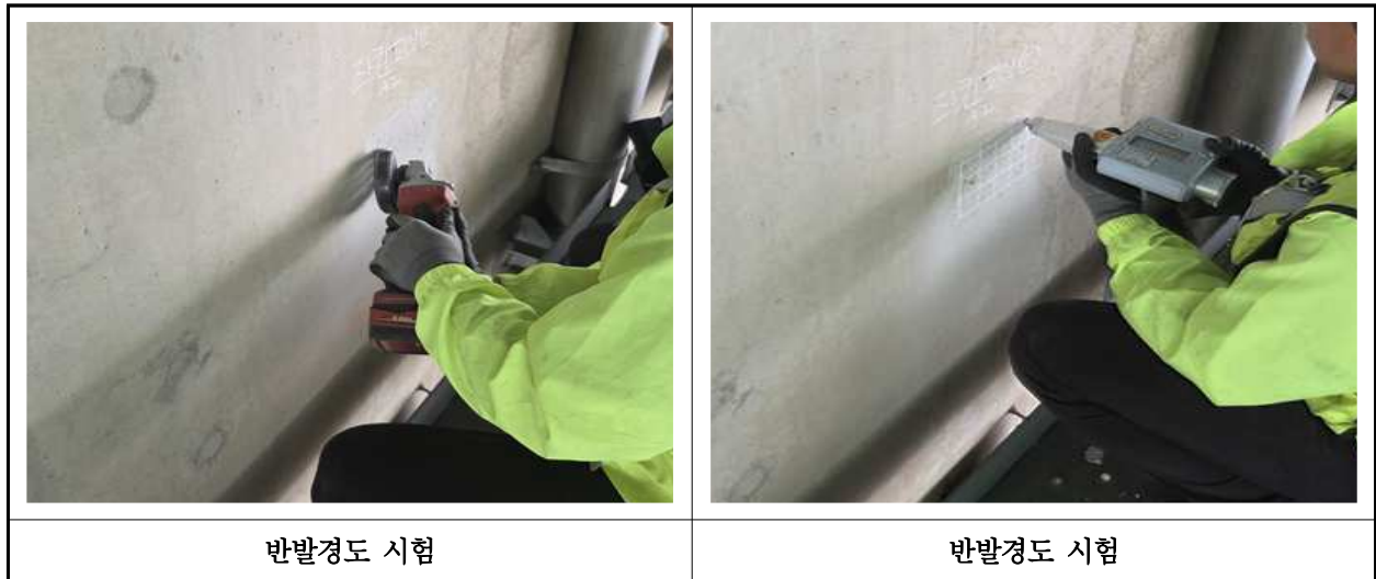
【사진 44.4.2】 반발경도시험 현장사진
