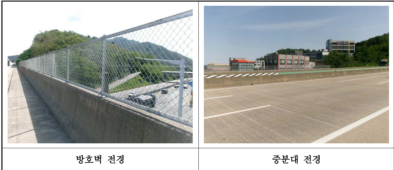
【사진 44.3.22】 방호벽 및 중분대 전경
