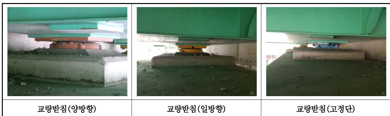
【사진 44.3.11】 교량받침 전경
