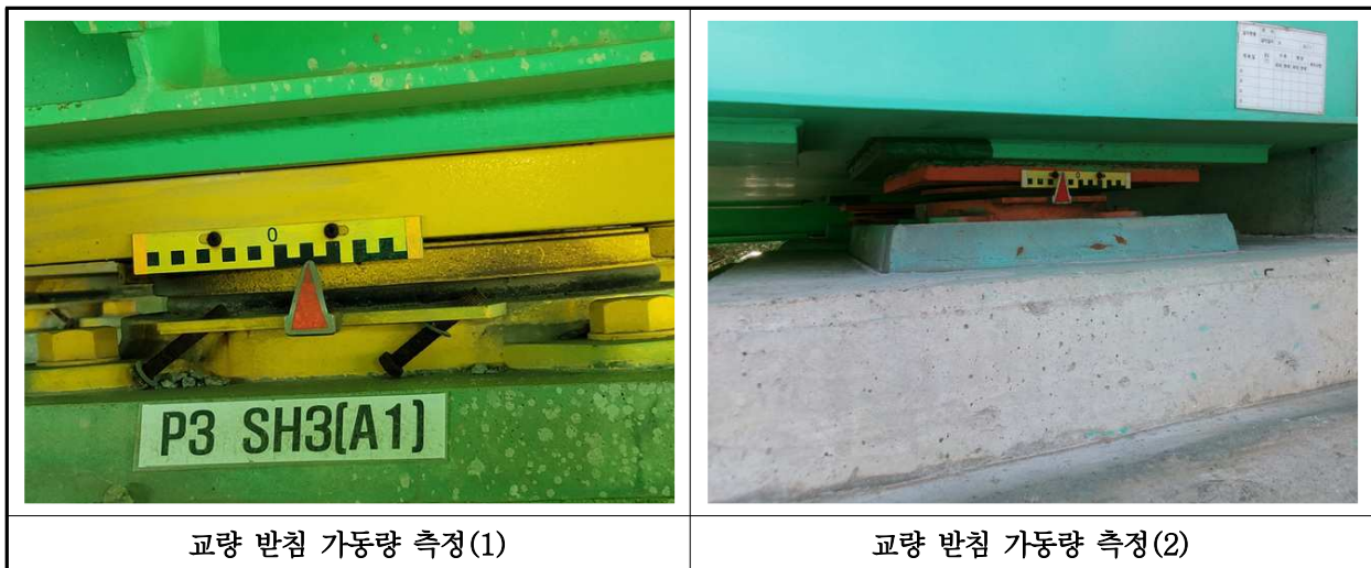
【사진 44.3.14】교량받침 이동량 측정
