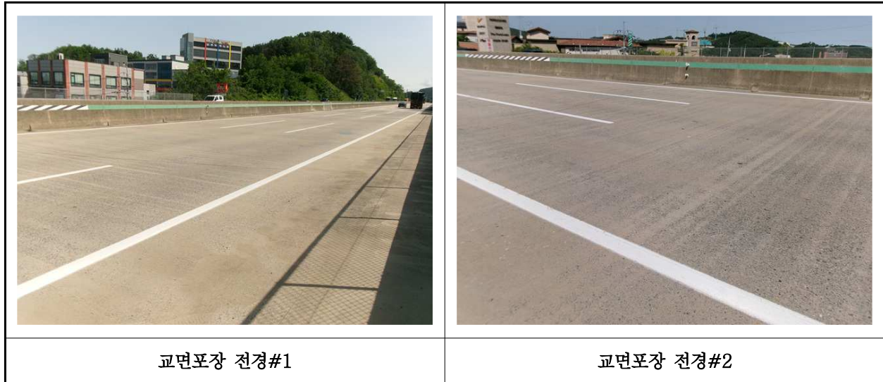
【사진 44.3.18】 교면포장 전경
